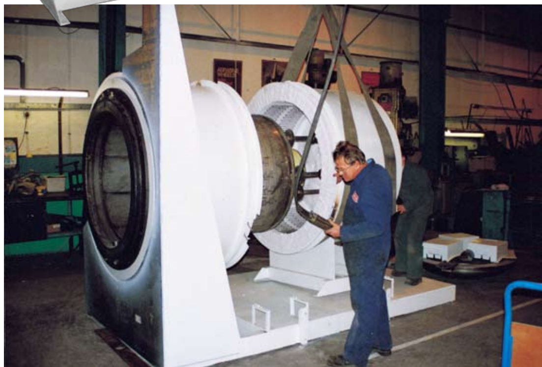
Рис. 30 Монтаж сегментов FIBROTHAL ROB для печи вакуумной очистки
