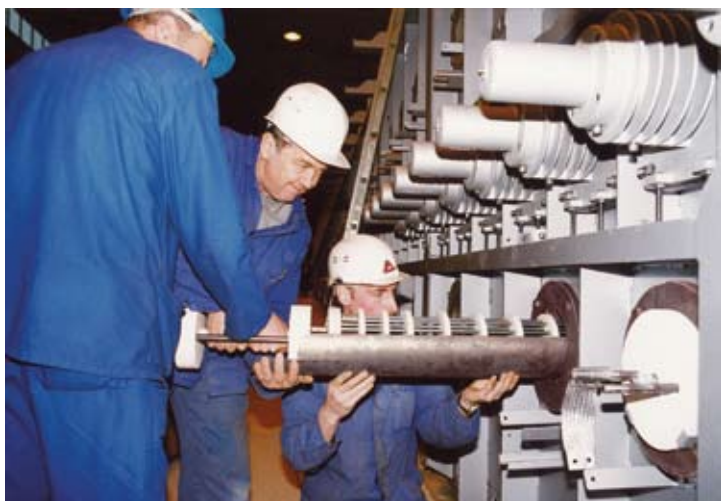
Установка РМ труб и нагревателей TUBOTHAL в линию непрерывного отжига
